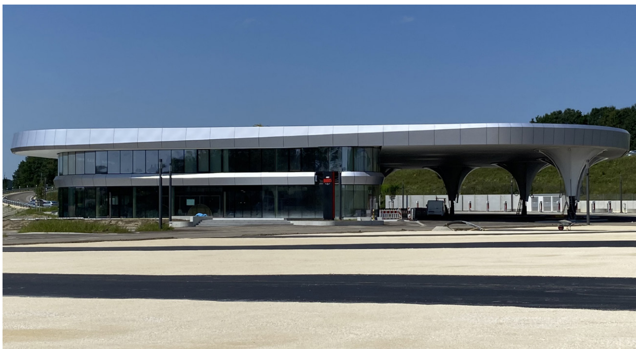
Außenansicht der größten Stromtankstelle in Zusmarshausen.
